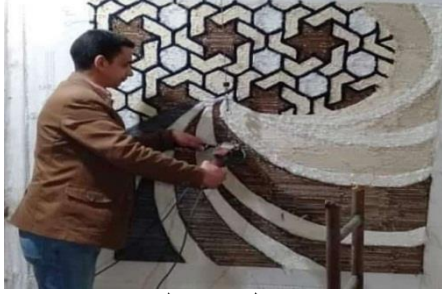
صورة (20) مراحل غرز الوبره باستخدام مسدس الهاند تافت "تنفيذ الباحث"
